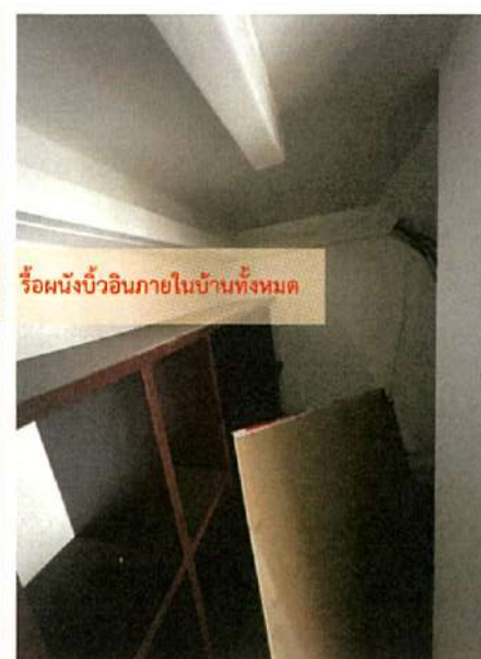
ผนังลอก Wall Paper แล้วฉาบปรับสภาพผิว ผนังด้วย IC Dulux Smooth Over
